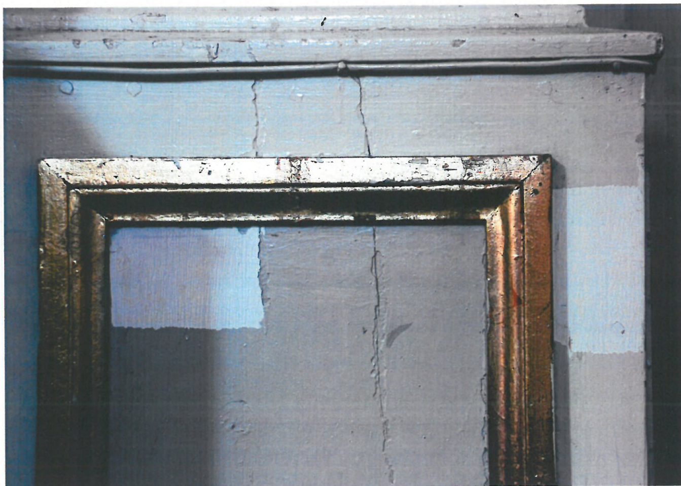
FOT. 16. Czerwin, Kościół Trójcy Św., Ołtarz Ukrzyżowania. Fragment cokołu ołtarza z odkrywką pierwotnej warstwy malarskiej.
