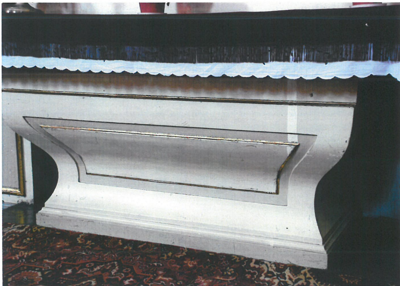
FOT. 15. Czerwin, Kościół Trójcy Św., Ołtarz Ukrzyżowania. Mensa ołtarza z widoczną po prawej odkrywką pierwotnej kolorystyki.
