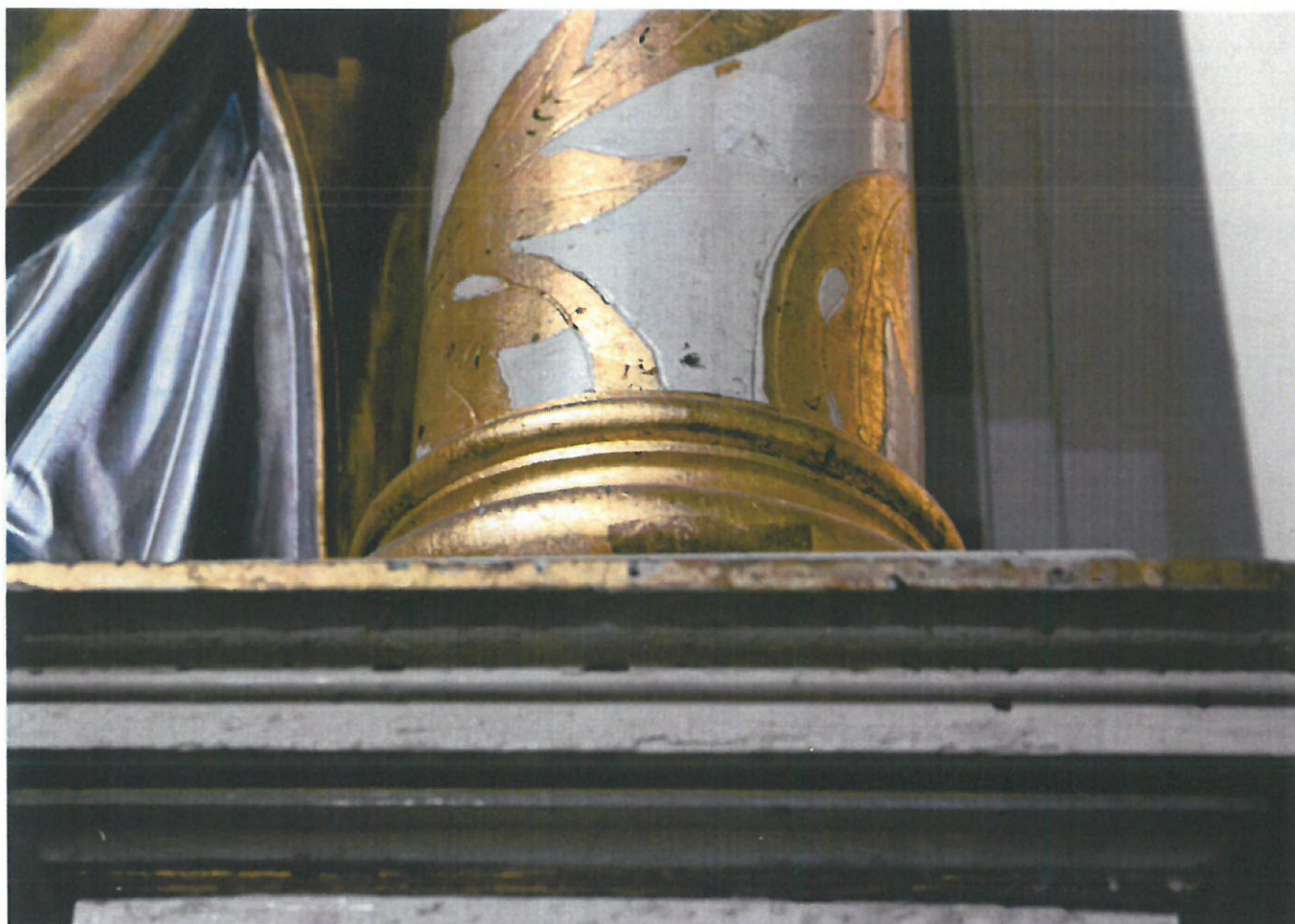
FOT. 12. Czerwin, Kościół Trójcy Św., Ołtarz Ukrzyżowania. Fragment kolumny z widoczną odkrywką pierwotnej kolorystyki.
