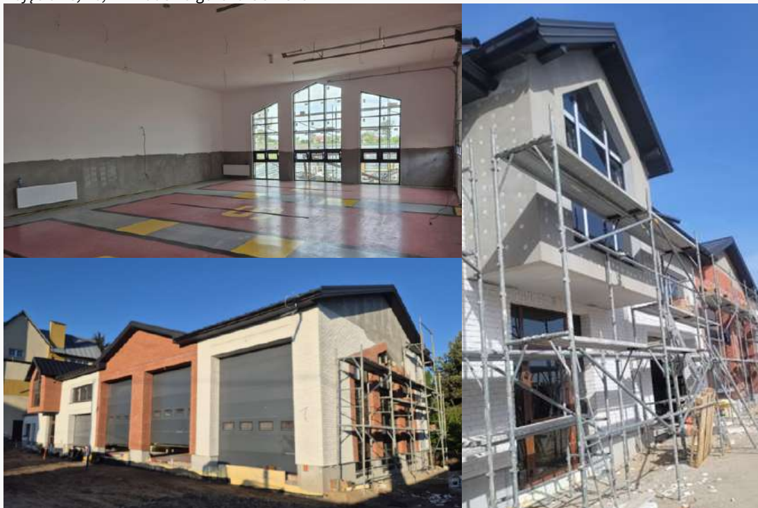
Zdjęcia 19, 20, 21. Budowa garażu OSP Czerwin
