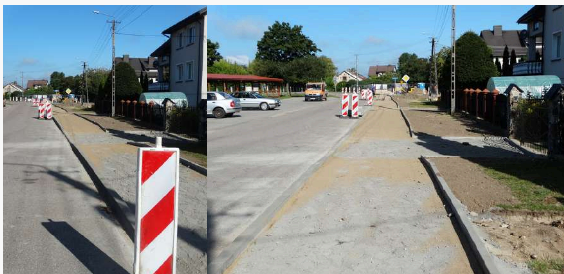
Zdjęcia 27, 28. Budowa chodnika na ulicy Wolności w Czerwinie
