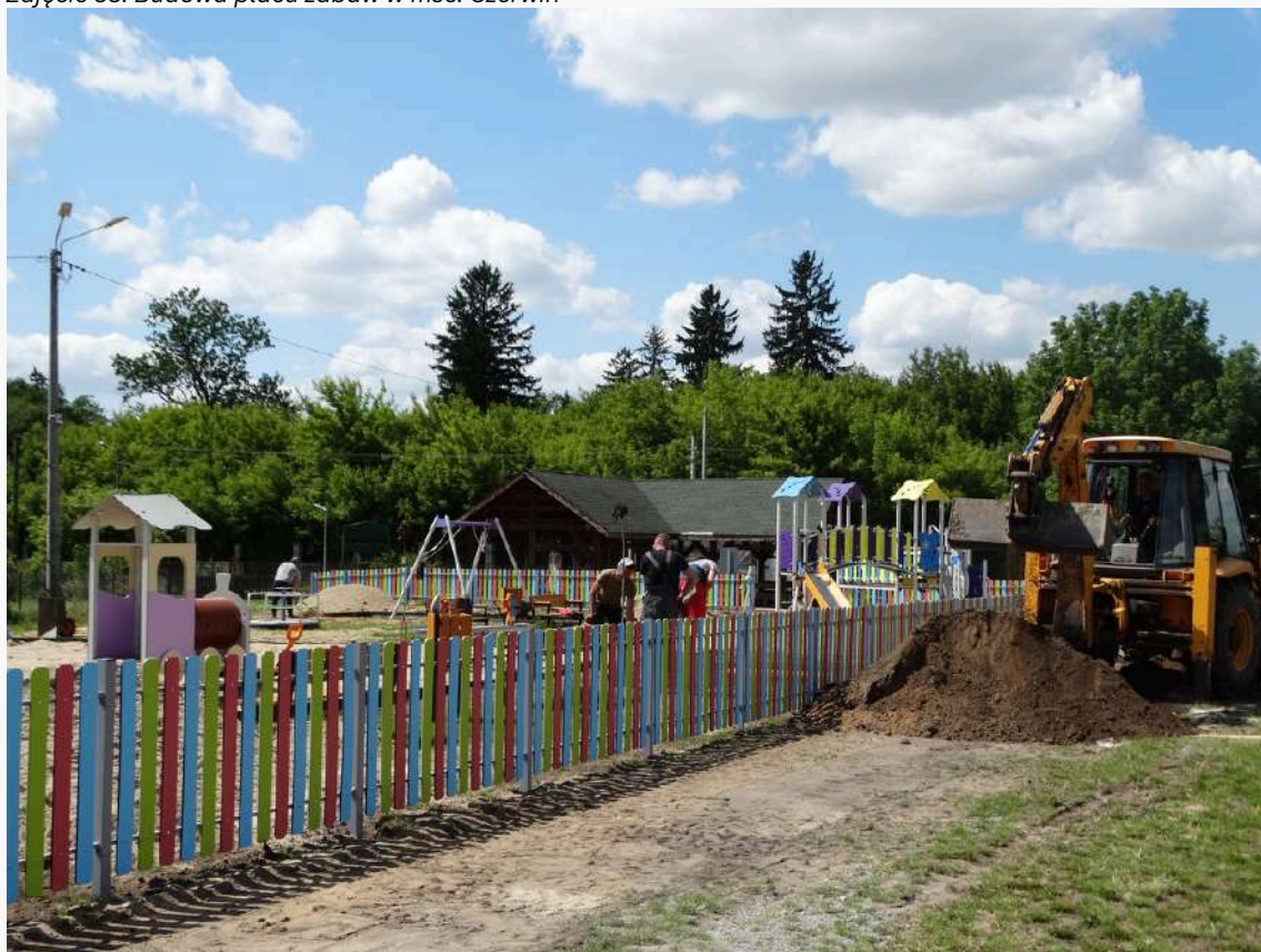
Zdjęcie 38. Budowa placu zabaw w msc. Czerwin
