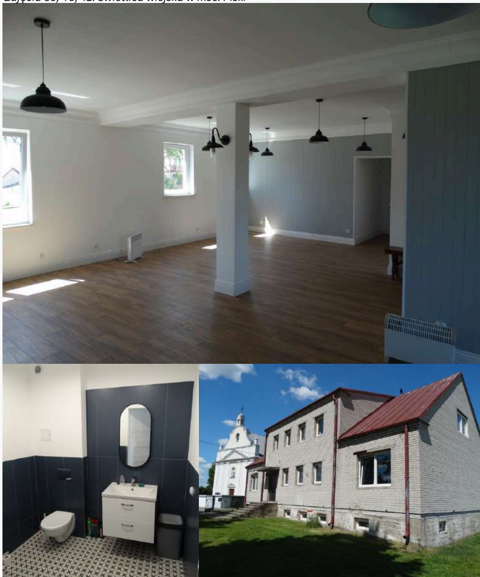
Zdjęcia 39, 40, 41. Świetlica wiejska w msc. Piski
