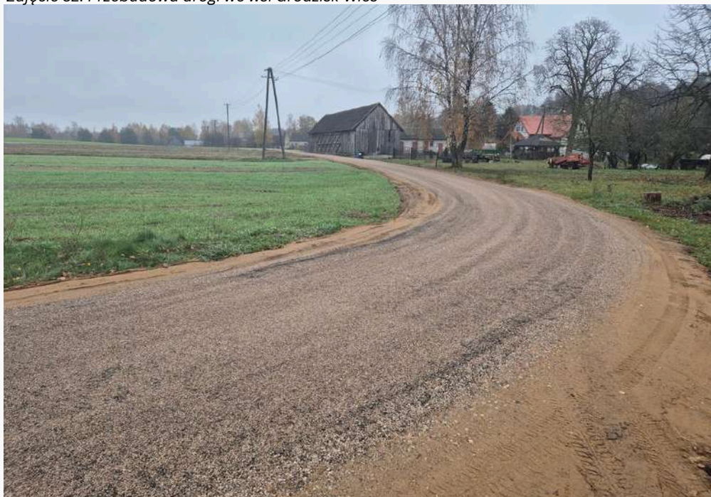
Zdjęcie 32. Przebudowa drogi we wsi Grodzisk-Wieś
